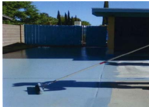
MT-16 Aplicada sobre cemento en entradas de vehículos y sobre MDF en una mesada
