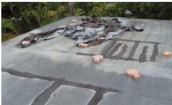
Vista de un Techo, antes y durante la aplicación del recubrimiento MT-18
