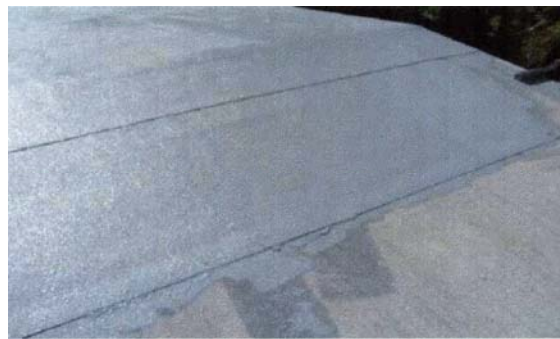
Vista de un Techo, antes y durante la aplicación del recubrimiento MT-18
